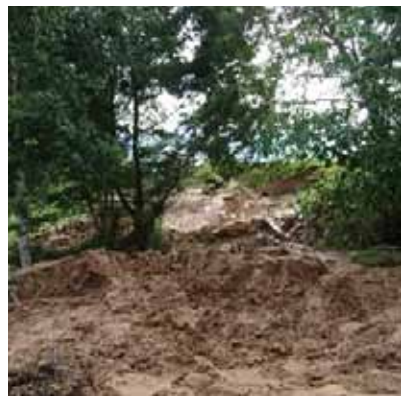
市道卯原内の土砂崩れ現場
