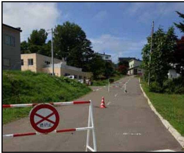
向陽ヶ丘北8号線の通行止め現場
